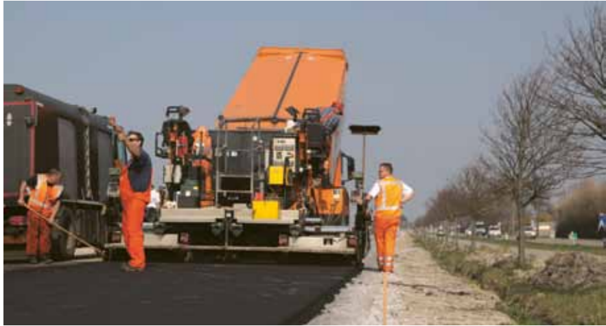
Asfaltploeg Rasenberg ter hoogte van de Kleine Putweg
