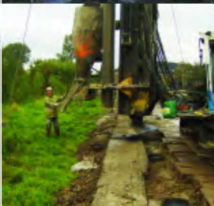
VIBRO-PALEN van Terracon Spezialtiefbau GmbH in Bremerhaven II Duitsland
